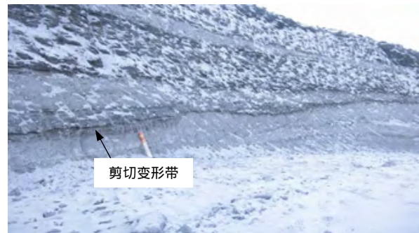
图 4 南帮边坡剪切变形
