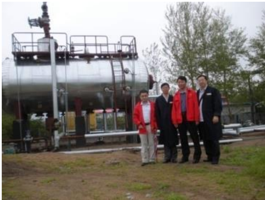
油气水多相分离器现场安装
