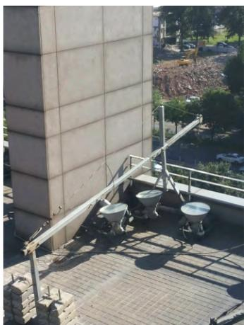
图 2 吊篮悬挂机构图
