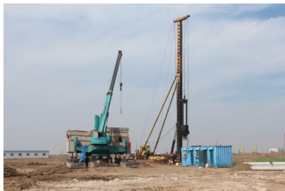
图 3 试验场地成桩施工照片
