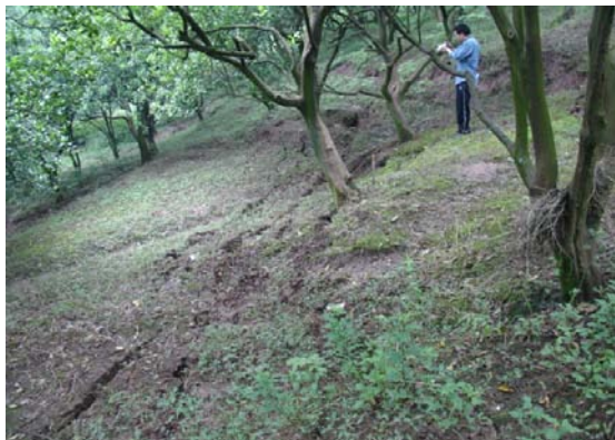
(b) 斜坡上的裂缝
