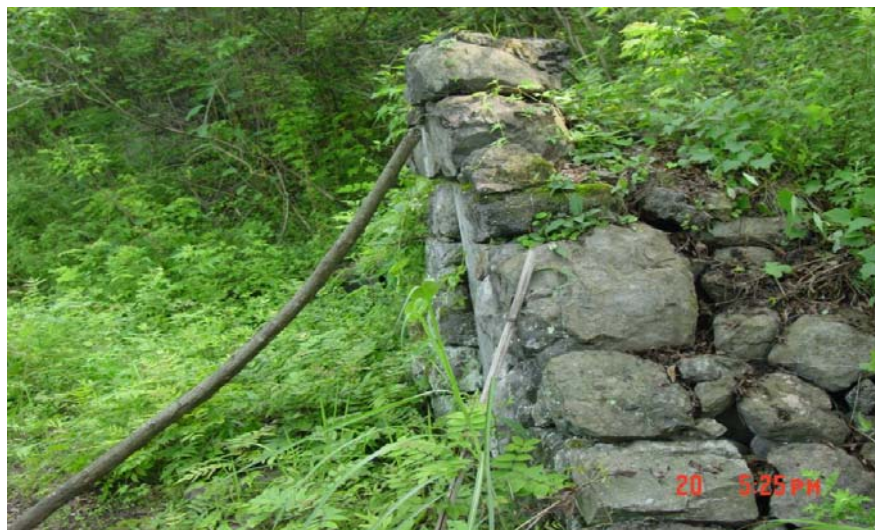
图 4-4 覃守运老房上方的坟头开裂并前倾
