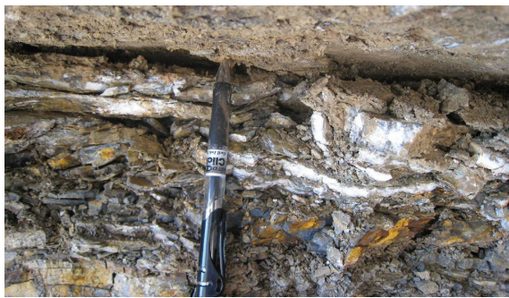
图 5 唐家山滑坡滑体层间剪切带照片
