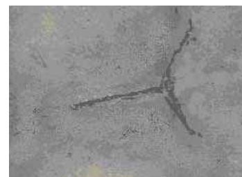
图 3 三条裂纹照片
