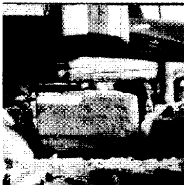
图9 木柱与石础的连接 (俞茂宏摄 1985) [1]
