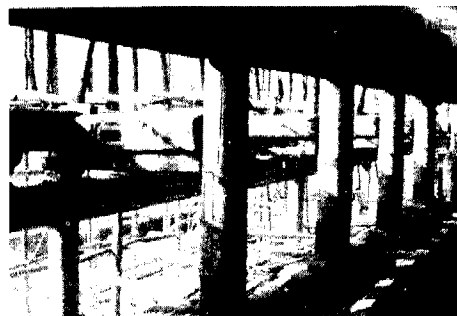
图4 立柱即将被砌入厚墙内(俞茂宏摄1986)
